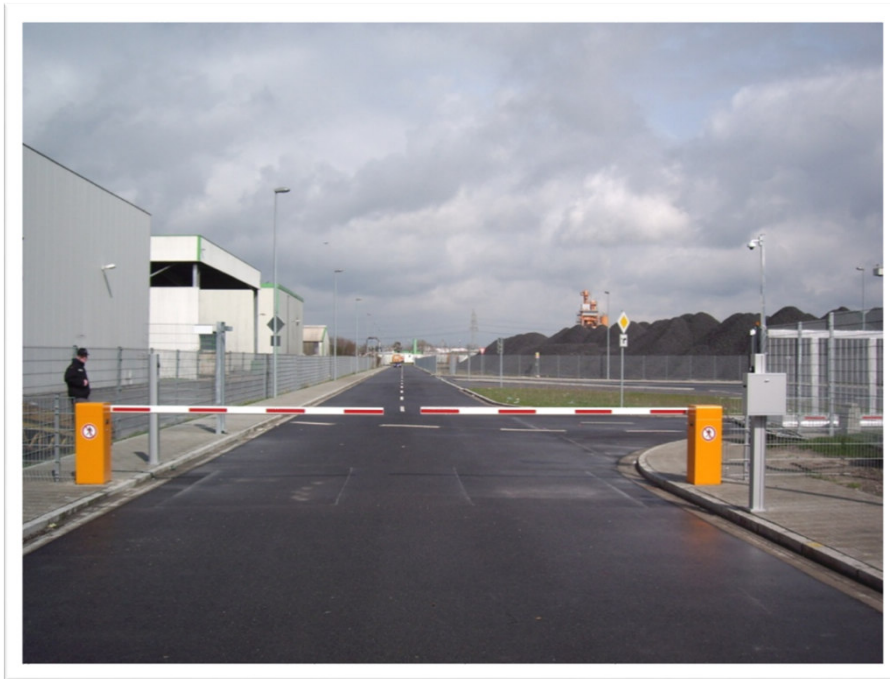
Doppelschranke MIB Kontrollierte Ein- und Ausfahrt über Zutrittsysteme
