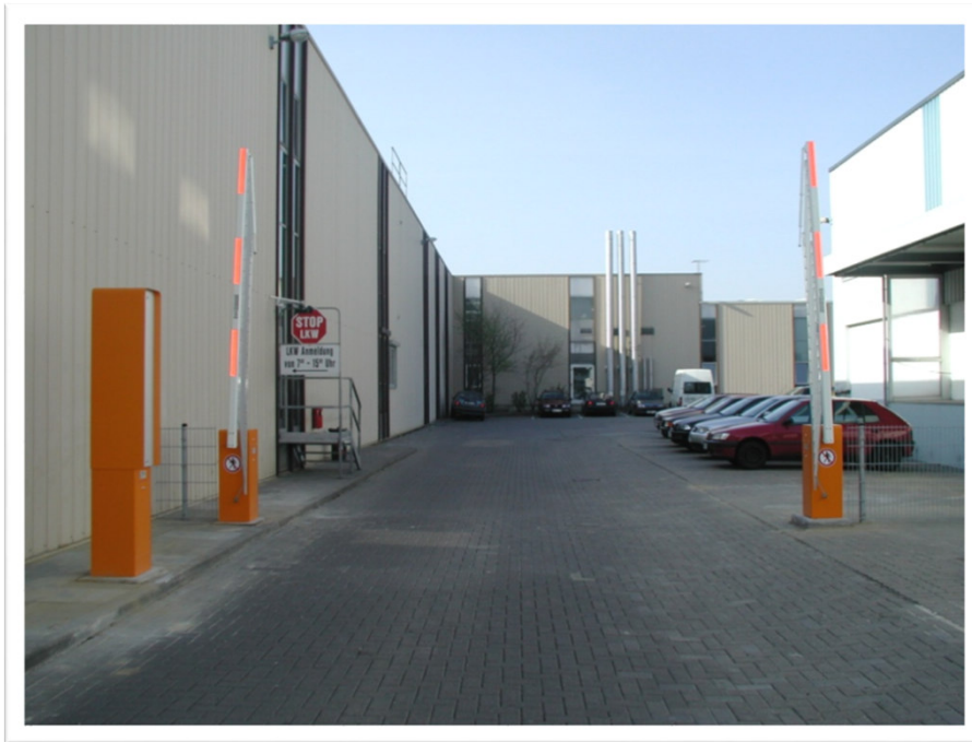
Werkzufahrt mit PKW/LKW Säule
