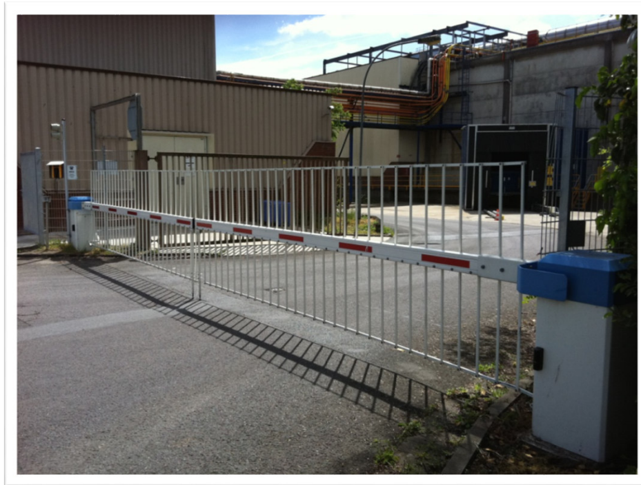
Doppelschranke ES 60 mit Gitter zur Absicherung des Werksgeländes
