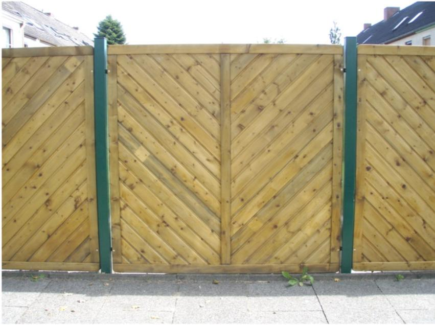
Die Pfosten stehen in Betoneinzelfundamenten. Das Gewährleistet einen sichern halt gegenüber Windlasten.
